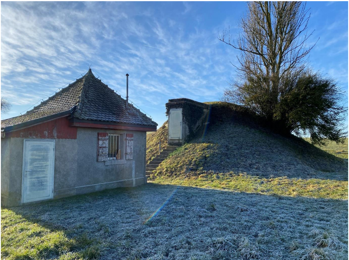
Figure 2: Station de pompage et réservoir (arrière-plan)
